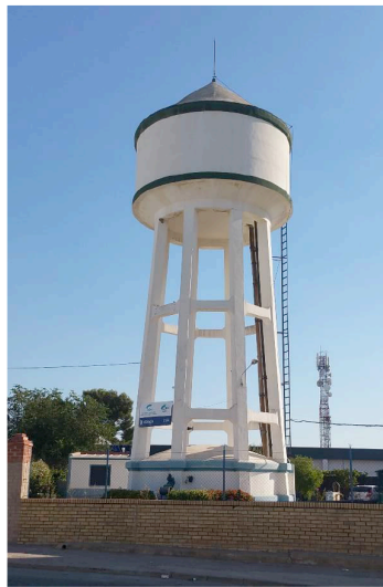
Depósito elevado de 215 m 3 , actualmente en desuso (construido en los años 20)
