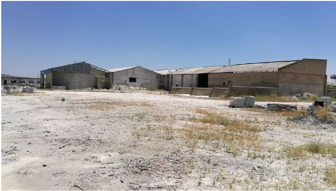
Edificaciones e Instalaciones existentes en la zona próxima al acceso a la parcela que van a ser demolidas.
